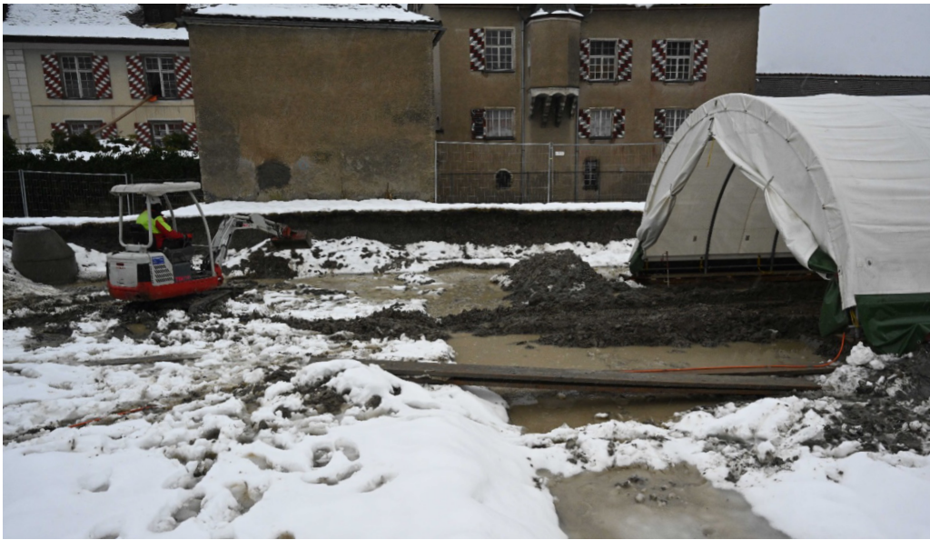
Beispiel einer Notgrabung im Bereich Zizers GR, Vialstrasse/Schlossbungert, ab Januar 2022 (© ADG)
