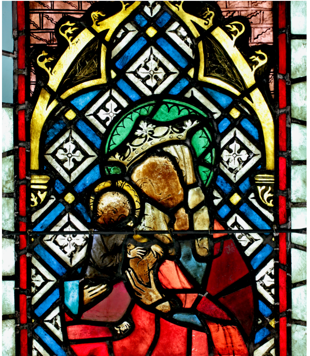
Glaskorrosion und Verlust von Schwarzlotmalerei: Einfluss von Feuchte und erhöhten Oberflächentemperaturen. Glasgemälde von etwa 1348 (Fragment mit Maria und Christkind) und 1926 in der Kollegiatkirche von Romont (FR) (© Jean-Louis Donzallaz)
