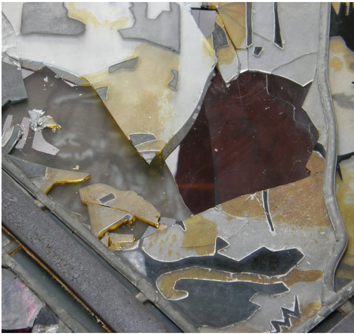
Vernichtender Hagelschaden von 2009 an mehrschichtigen Glasmalereien von Alexandre Cingria, Kollegiatkirche von Romont FR um 1940 (© Stefan Trümpler)
